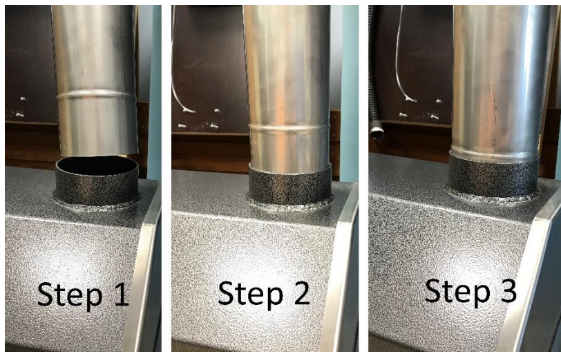
Kuva 9. Savupiipun asennus
